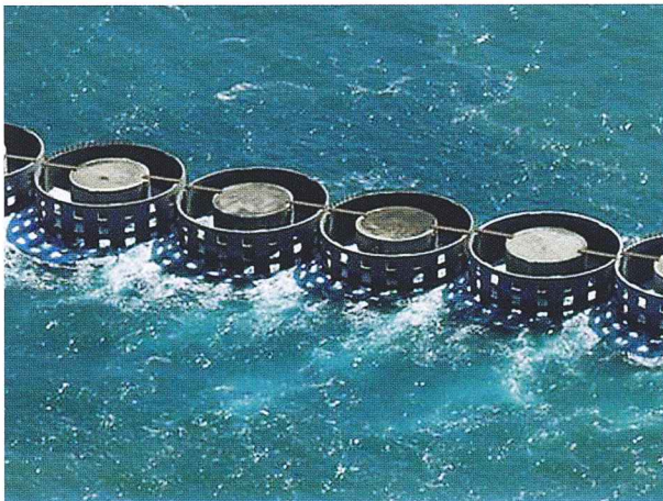
▼ナスサンド.Sが中詰め材として使用されたケーソン
