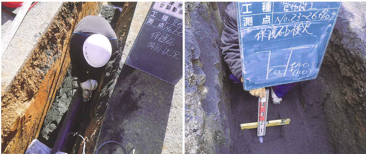
▼ナスサンド.Sをインターロッキングの敷砂として使用した現場
