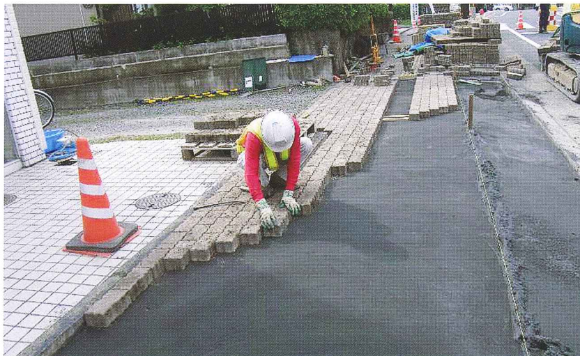
▼ナスサンド.Sをインターロッキングの敷砂として使用した現場
